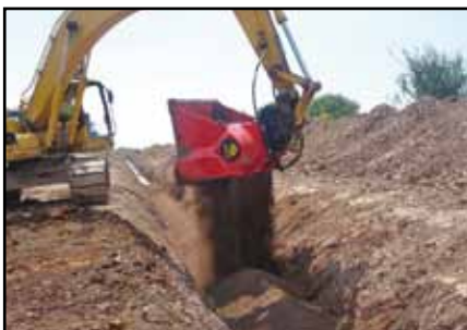
Pijp leiding aan vullen
