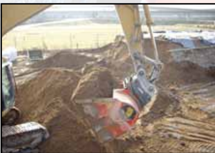
Stabiliseren van fundering lagen
